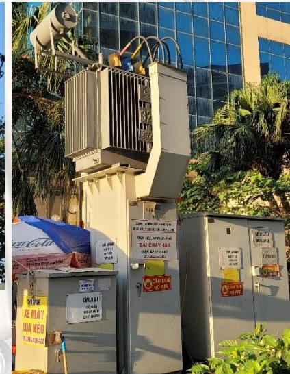
전기전자공학과로서 지나칠 수 없는 변압기들의 모습. (배전용 유입변압기 Điện áp 22kV/0.4kV ►)
